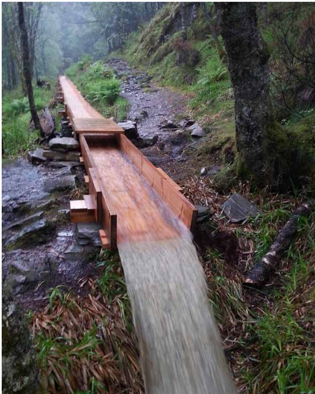
TILBAKEFØRT: Rennesystemet bygget på slutten av 1800-tallet, er et kulturminne som forteller om mølledriften i Sandviken. Rekonstruksjonen er derfor viktig mener buekorpsgutter i bydelen.
