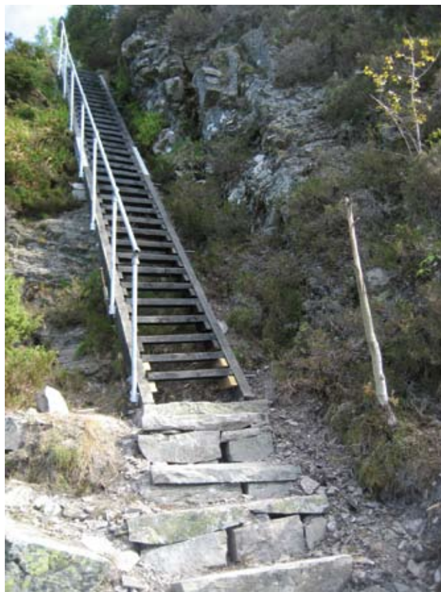
Den nye tretrappen nedenfor Ravneberghytten som Dræggeguttene har fått laget.
