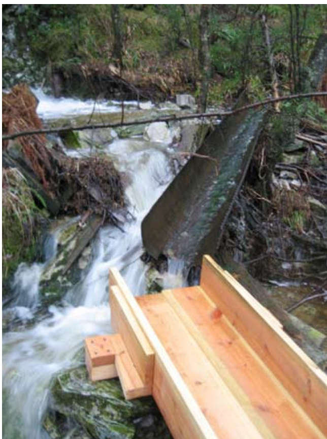
Modellen av trerennen plassert ut i bekken der den originale rennen tidligere lå.
