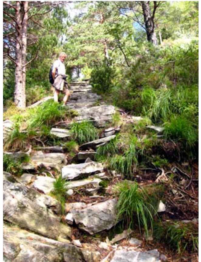
Denne trappen trenger utbedring.
