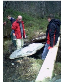
2007 Rekonstruksjon av kloppen ved Ravneberghytten
