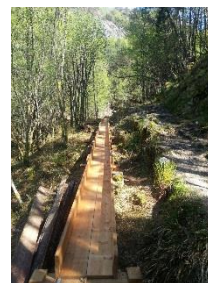
2013 Bygging av trerennen
