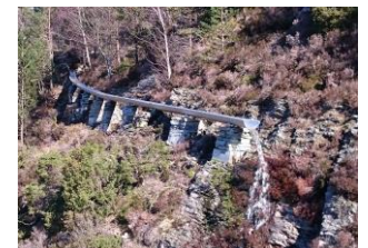
2015 Ferdigstilling av stålrennen
