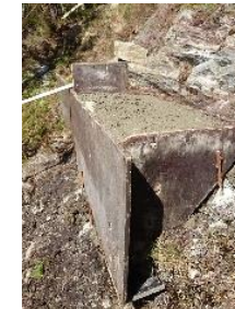
2014 Bygging av stålrennen
