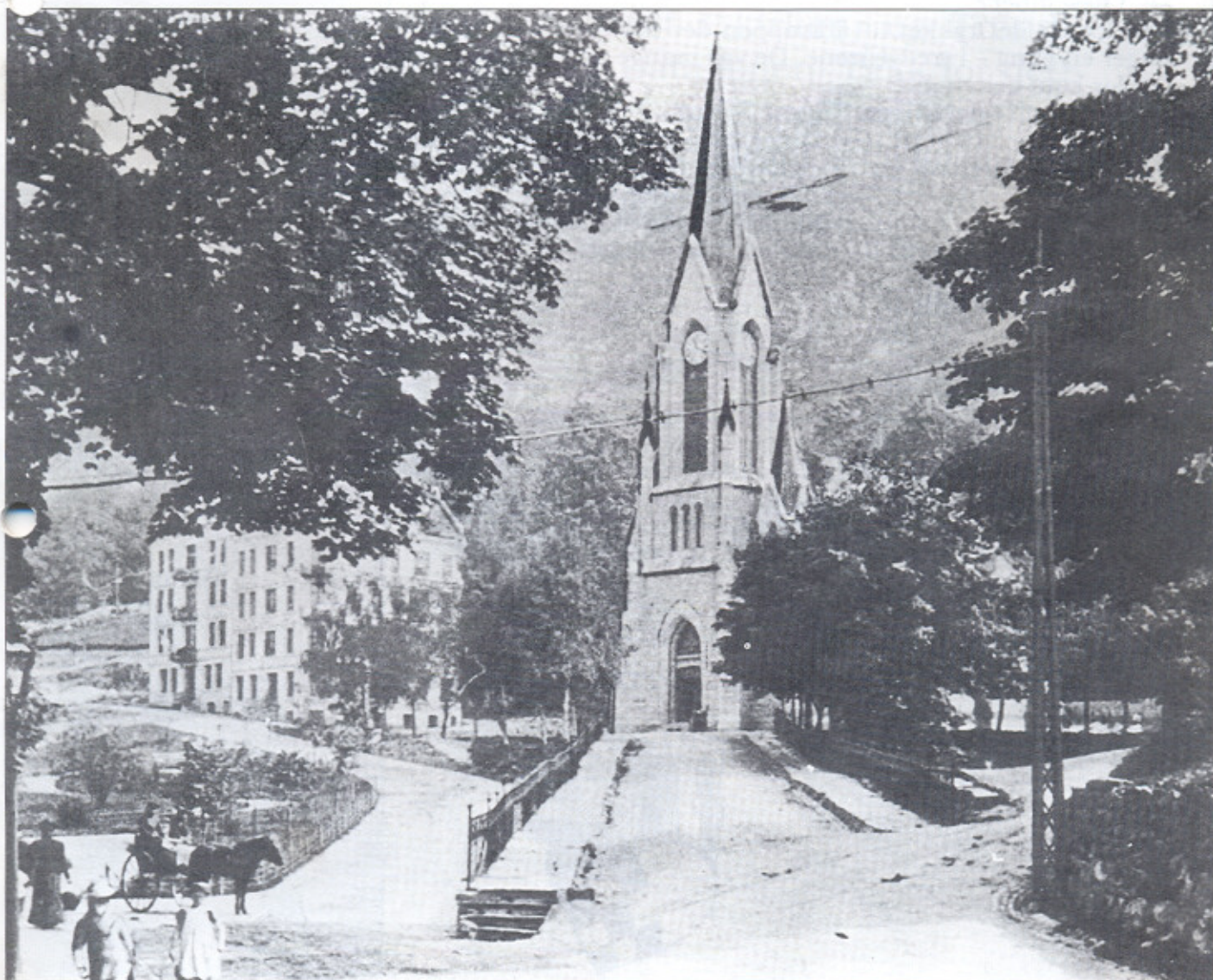
Sandvikskirken ca. 1890. De første husene i Kirkegaten er bygget.
