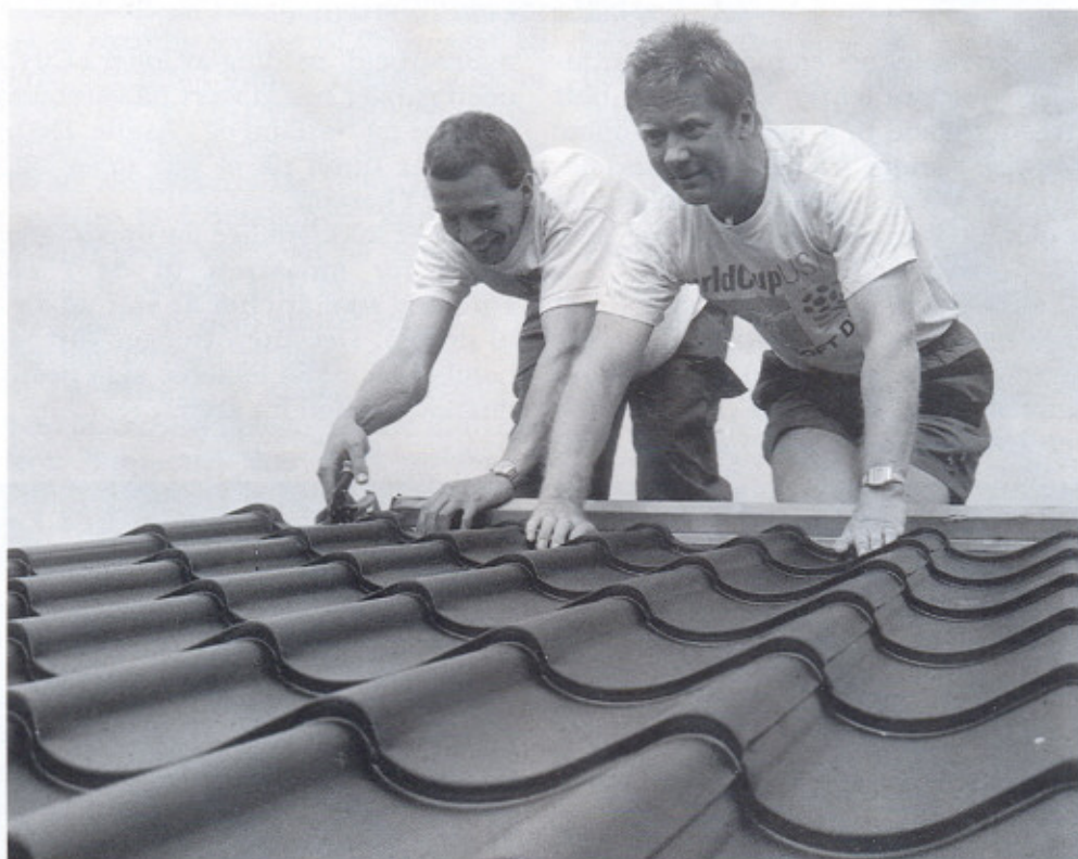
Fra skifting av taket på Hytten i 1999. Vi ser fra venstre: Stein Ove Natland og Helge Olsvold. Foto: Raggen.
