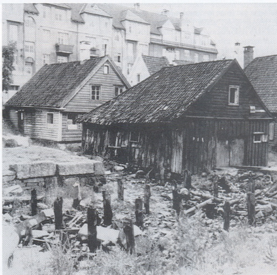
Lahnenøstet og Sandviksvei 42a på 1950-tallet da forfallet alt hadde satt sine spor. Sjøpelt overalt og de sprikende stökkene vitner om en svunnen tid. De store steinene i Kaimuren er kleberstein (og muligens rester fra en nedrevet middelalderkirke?).
